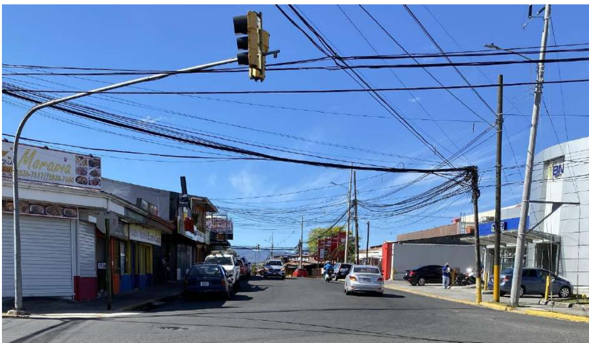
Figura 16. Acceso Sur de intersección de Banco Nacional, sistema 1140100017.
