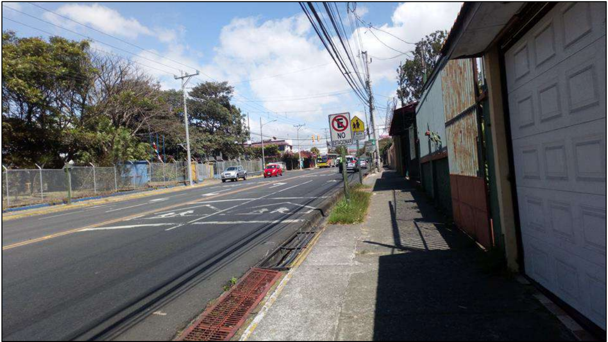
Figura 4 Señalamiento vertical de no estacionar con demarcación de zona escolar, acceso este de intersección ruta nacional n.º 109 - ruta nacional n.º 102, San Vicente de Moravia.
