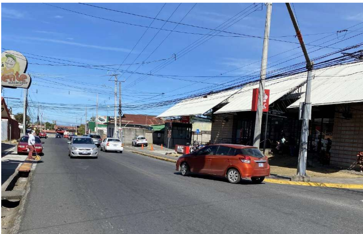
Figura 15. Acceso Oeste de intersección de Agencia BAC Moravia, sistema 1140100019.
