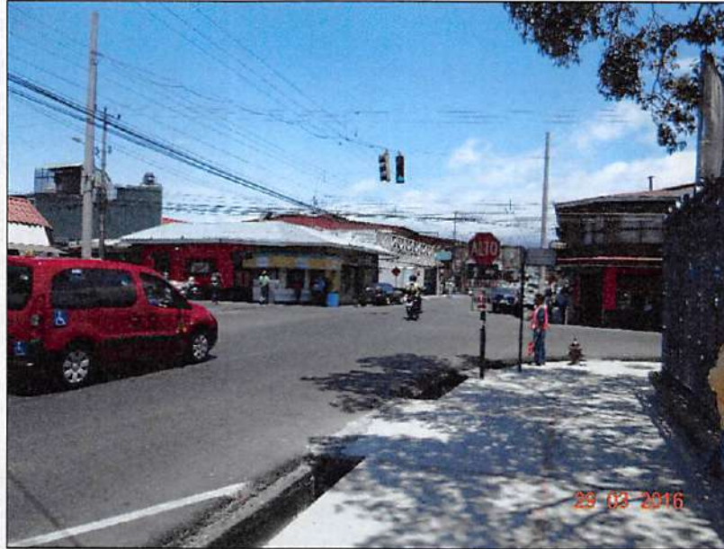
Figura 8 Señalamiento vertical en buen estado y ausencia de señalamiento horizontal, intersección noroeste de la iglesia.
