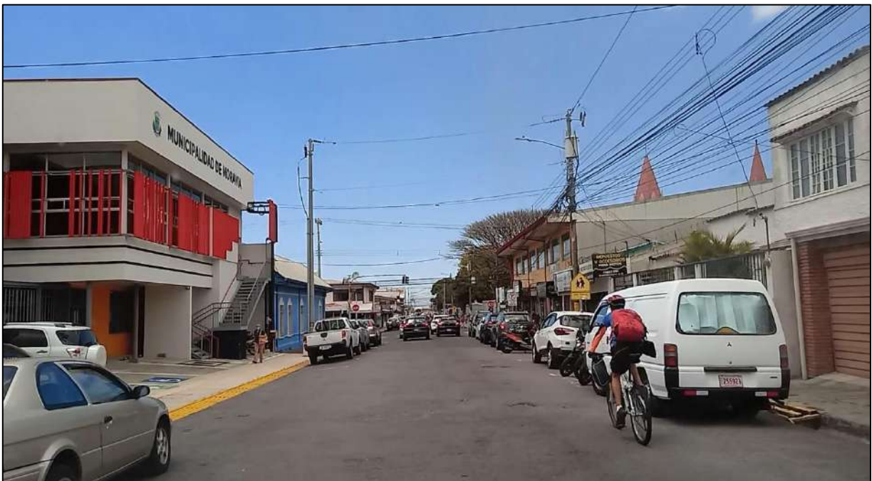
Figura 6 Acceso Este de intersección Calle 67-Avenida 63, Municipalidad de Moravia.
