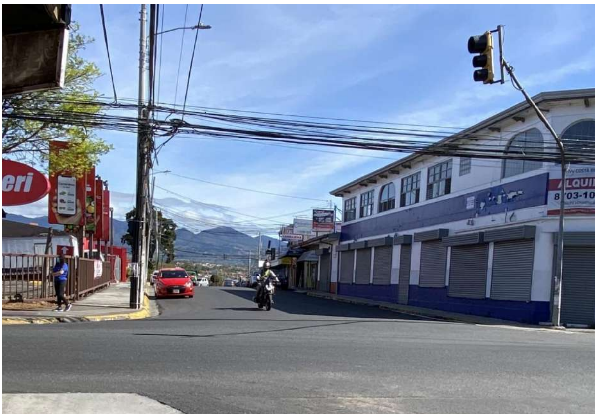
Figura 16. Acceso Norte de intersección Esquina NO Parque Moravia, sistema 1140100018.
