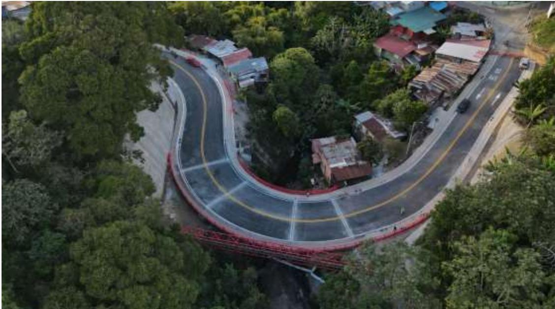
estructura, el elemento cuenta con la construcción de accesos y los elementos de seguridad, está pendiente la actividad de obras de protección que se ejecutan fuera de la superficie de ruedo y adecuaciones a nivel de entronques con lo existente.
