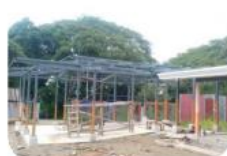
Construcción obra nueva
